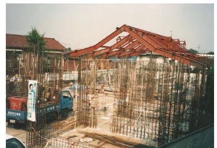
現聖堂建設中の様子
